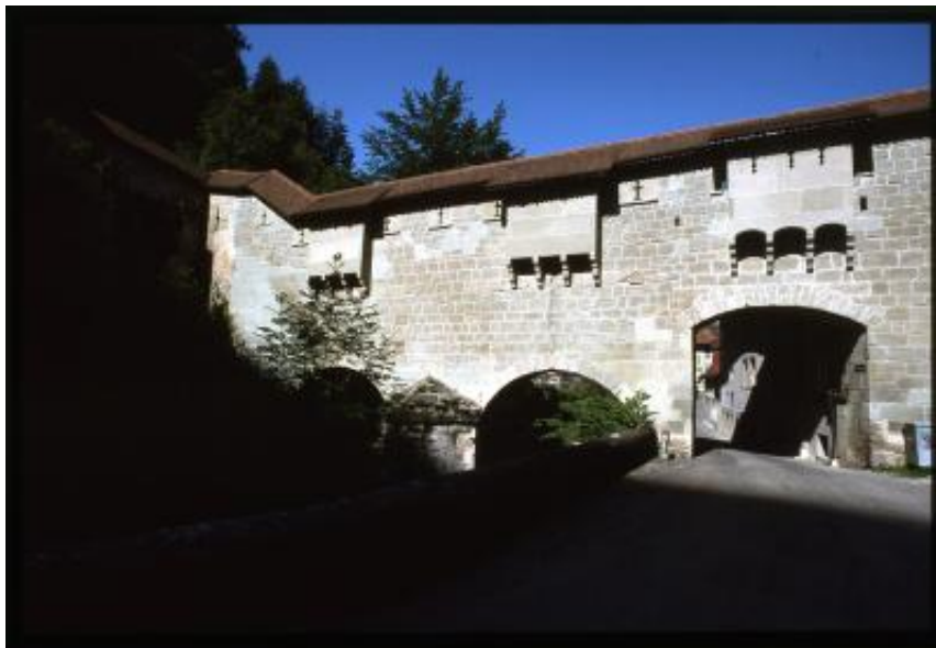
Friburgo. Mura medievali all'altezza della Porte du Gottéron
