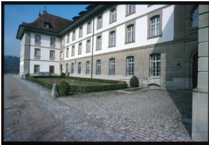
Hauterive. Dettaglio di una delle facciate dell'abbazia
