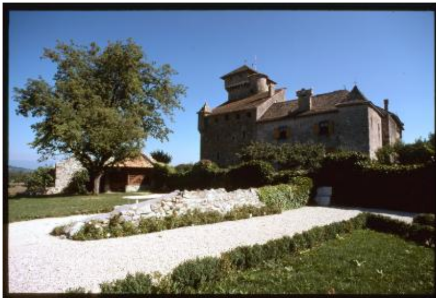
Avully. Facciata ovest del castello di Saint Michel
