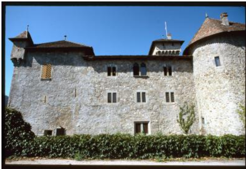
Avully. Facciata est del castello di Saint Michel
