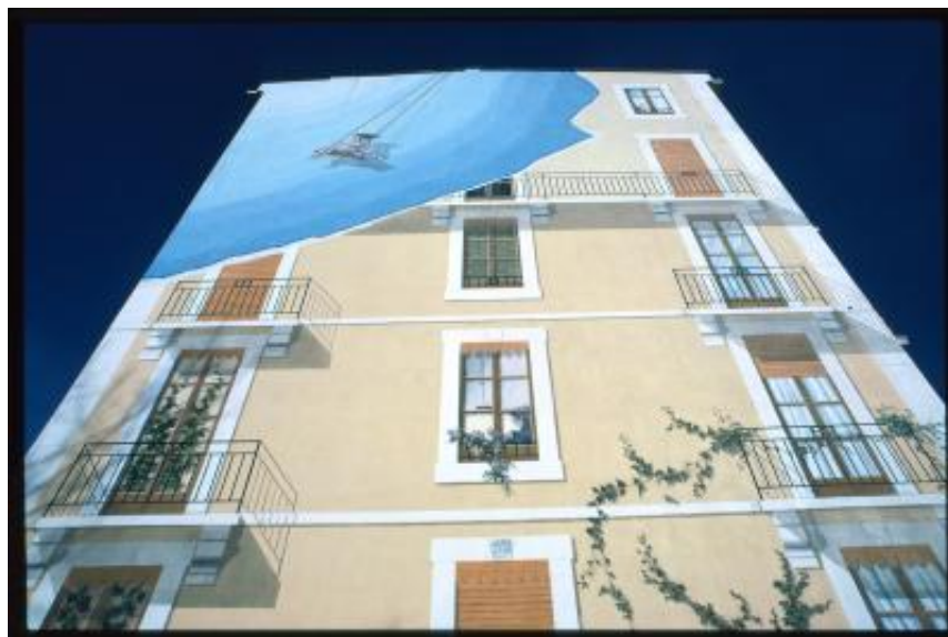
Carouge. Dettaglio della facciata affrescata di un palazzo
