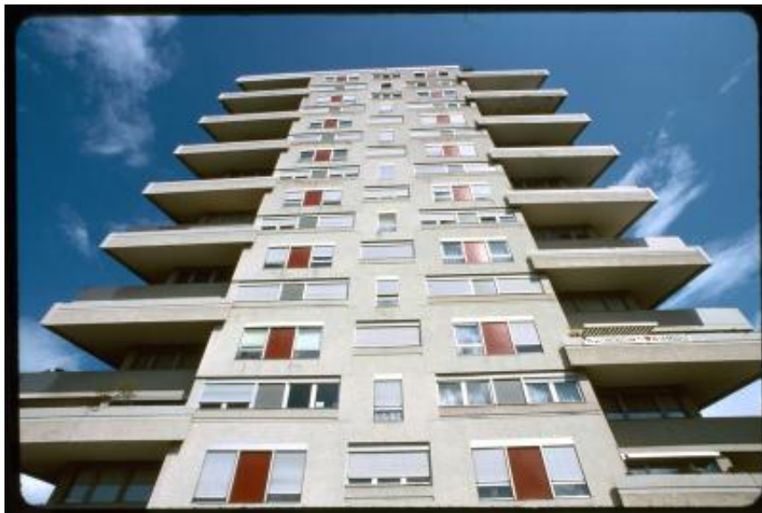
Cologne. Facciata di un edificio nel quartiere La Gradelle
