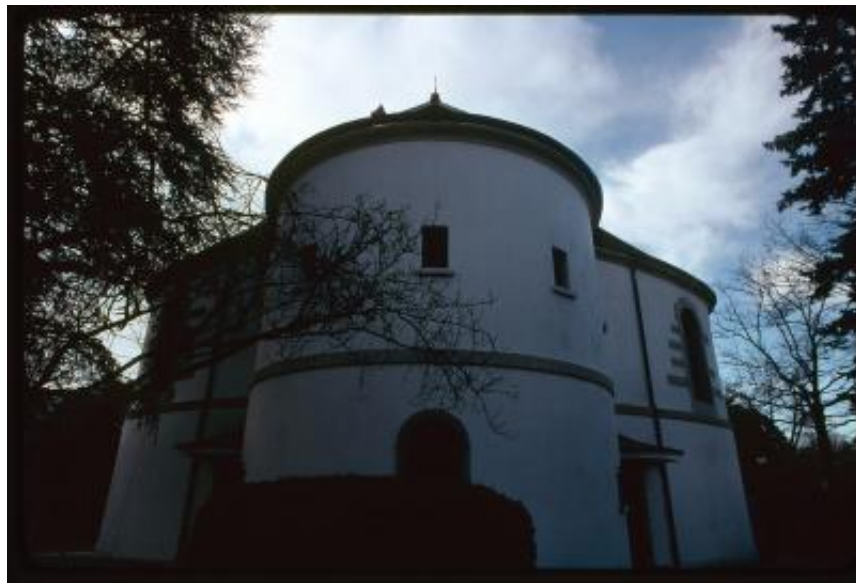
Chêne-Bougeries. Parte absidale della chiesa riformata
