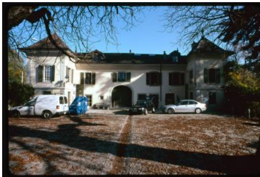
Chêne-Bougeries. Facciata, vista frontalmente, di un edificio in Grange-Falquet
