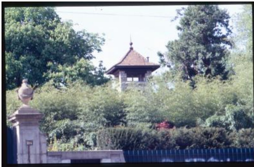
Chêne-Bourg. Dettaglio di un edificio in Rue de Chêne
