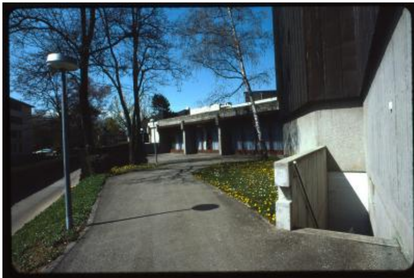
Thônex. Dettaglio di un complesso in Avenue Tronchet
