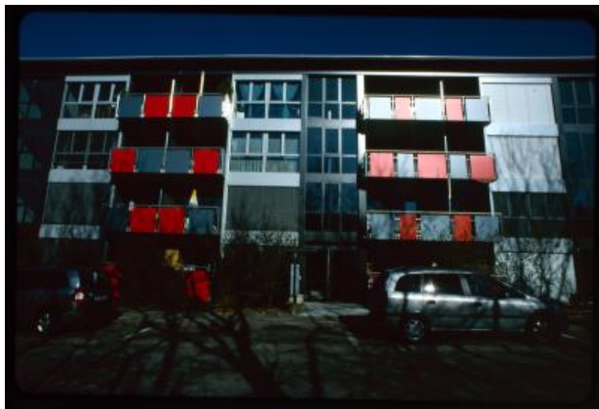
Confignon. Facciata di un edificio del quartiere di Cressy
