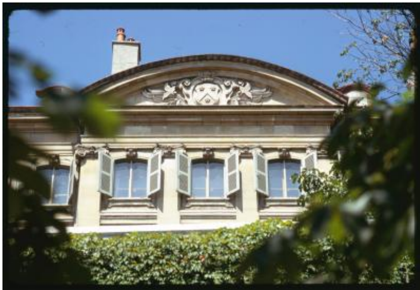
Ginevra. Frontone della Maison Boissier-Dominicé, in rue des Granges 4
