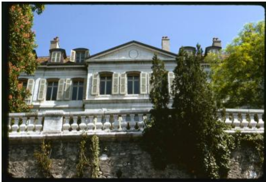
Ginevra. Facciata secondaria di un palazzo in rue des Granges
