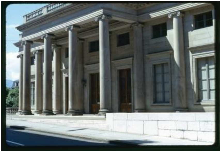
Ginevra. Ingresso di Palazzo Eynard
