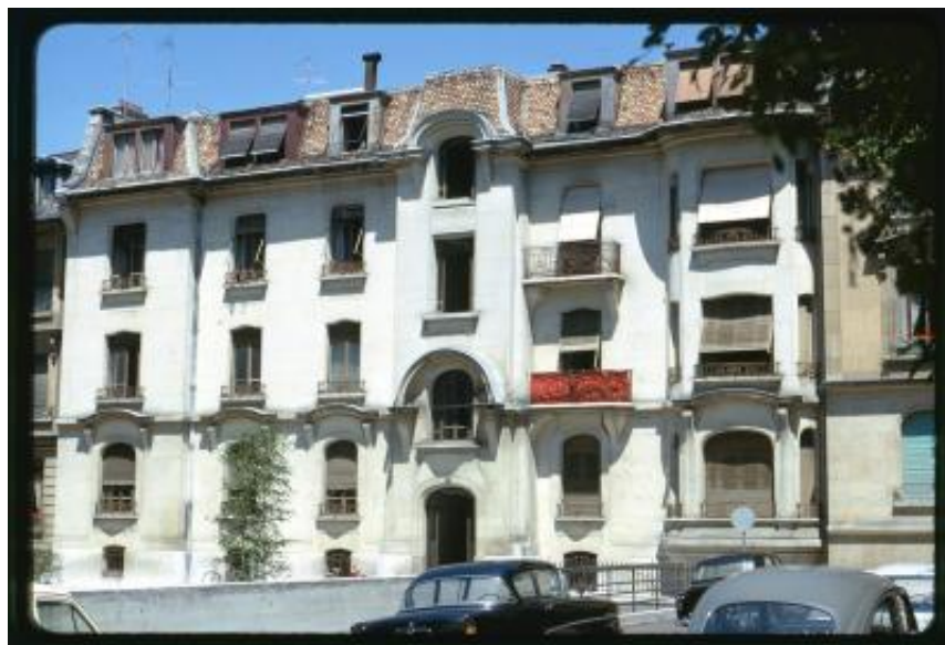
Ginevra. Facciata di un palazzo in rue Monnier
