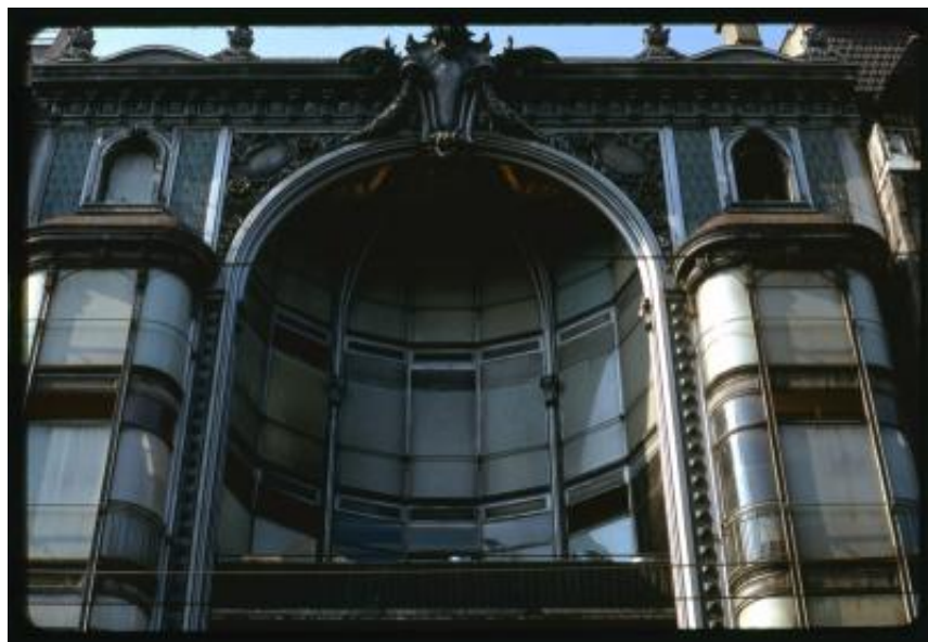
Ginevra. Dettaglio della facciata di un palazzo in stile Liberty in rue de la Croix d'Or
