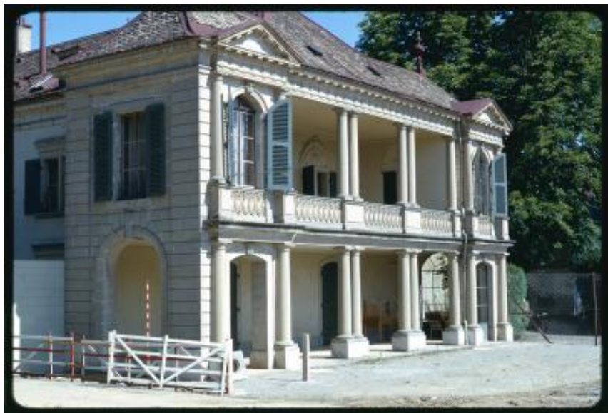
Ginevra. Facciata della Villa du Bouchet
