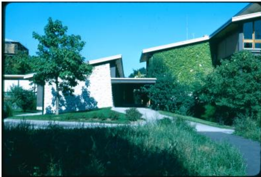
Veduta dell'edificio ospitante la scuola Geisendorf
