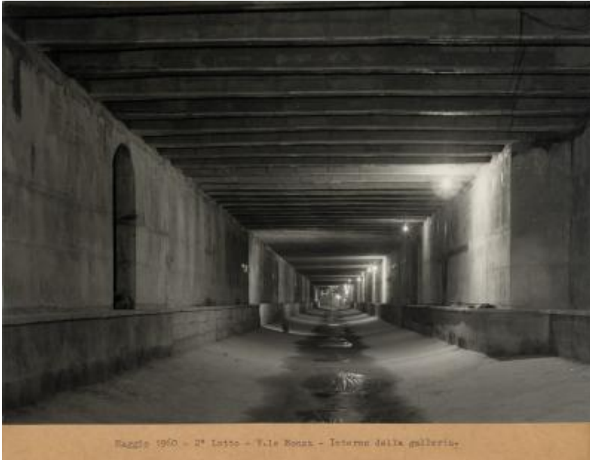
Interno della galleria di viale Monza
