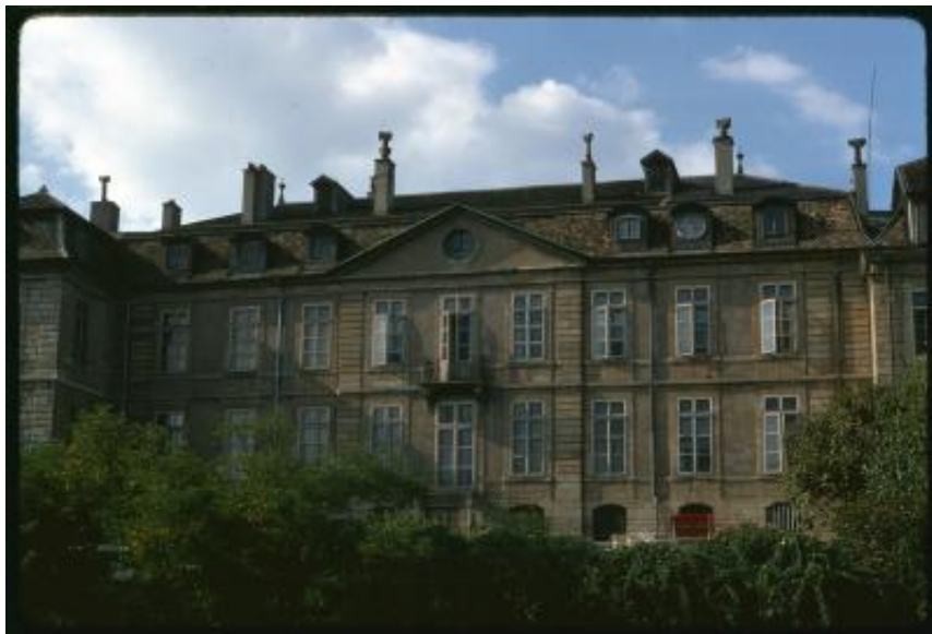
Facciata principale dell'Hôtel Buisson, ripresa dal basso
