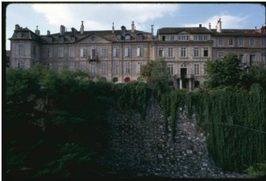
Facciate principali della Maison Buisson e degli edifici limitrofi, ripresi da sotto le mura
