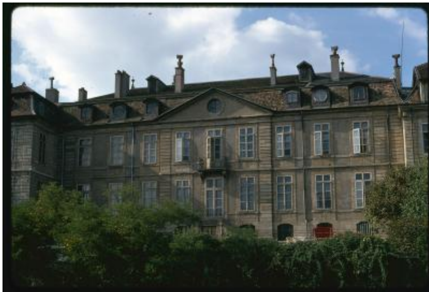
Facciata principale dell'Hôtel Buisson, ripresa dal basso
