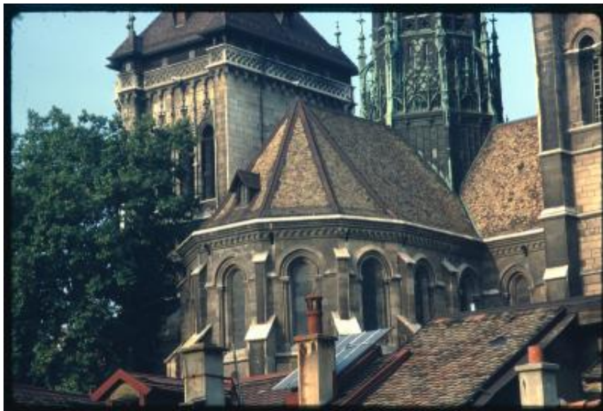
Ginevra. Parte absidale della cattedrale
