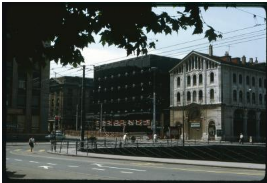
Palazzi all'imbocco di Rue de la Corraterie da Place de Bel-Air
