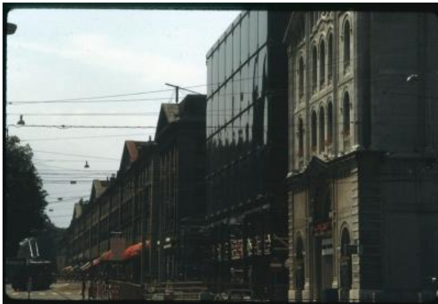
Palazzi sul lato ovest di Rue de la Corraterie
