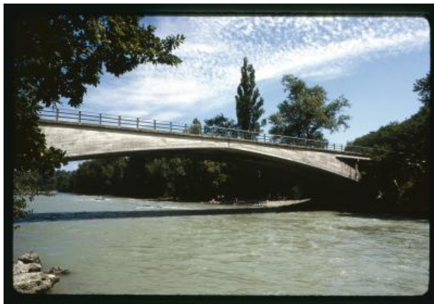
Ponte di Vessy
