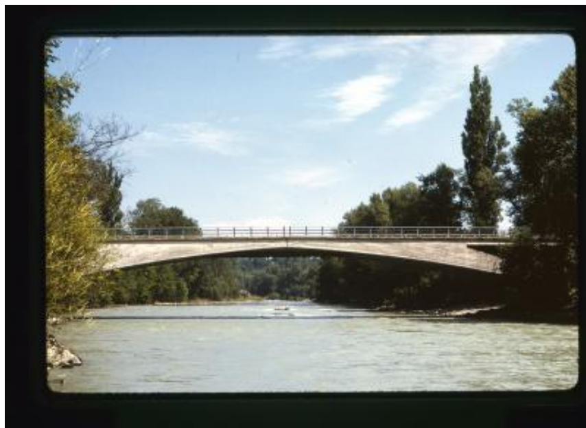
Ponte di Vessy
