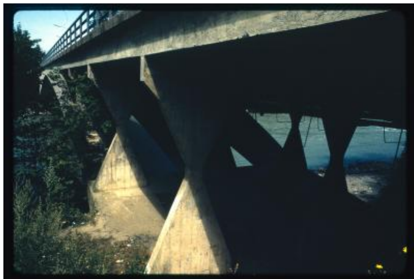
Spalla con piloni a doppio triangolo del Ponte di Vessy
