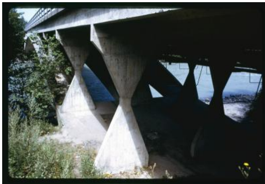
Spalla con piloni a doppio triangolo del Ponte di Vessy
