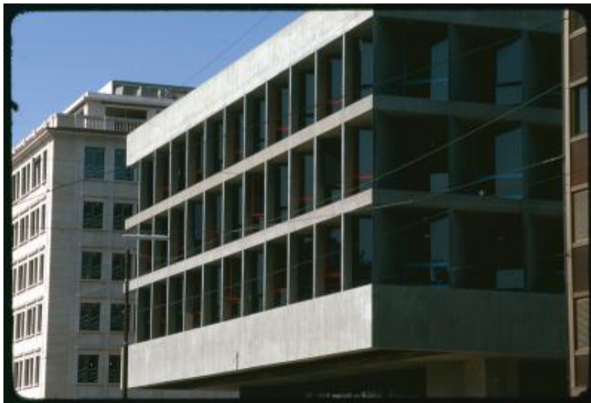
Ginevra. Facciata dell'edificio dell'Università II visto da Boulevard Georges-Favon
