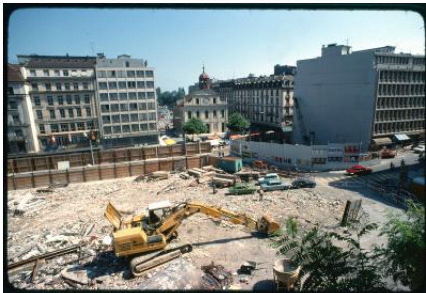
Ginevra. Tempio della Fusterie con cantiere antistante, ripresi dall'alto
