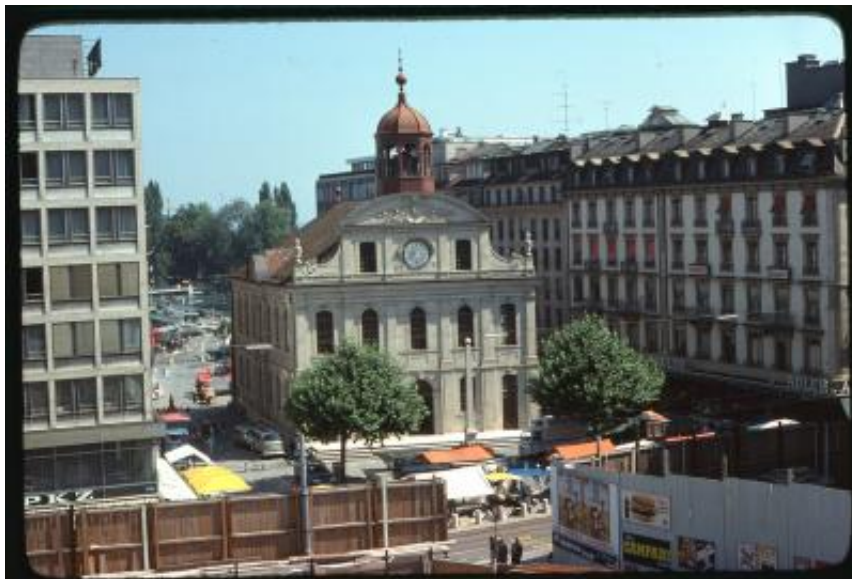
Ginevra. Tempio della Fusterie e il cantiere antistante ripresi dall'alto
