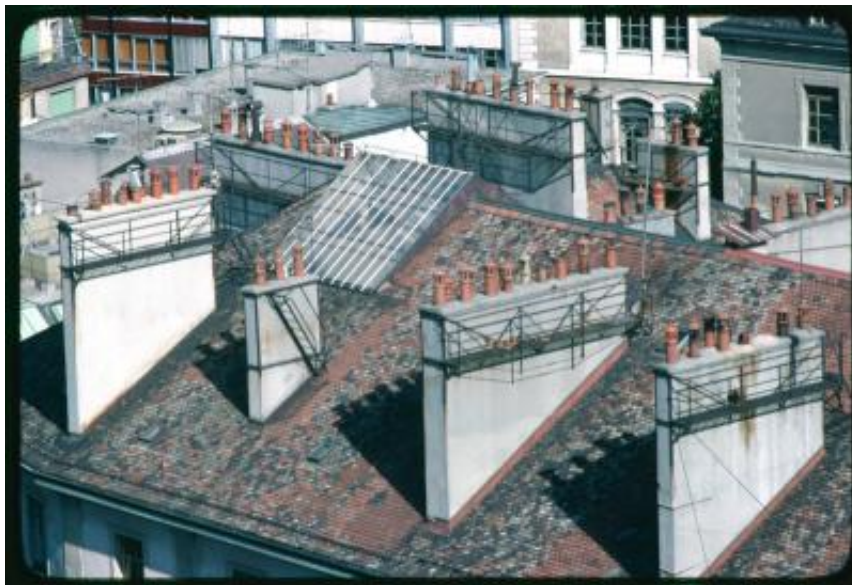
Ginevra. Dettaglio del tetto dell'edificio in rue Verdaine al civico 11
