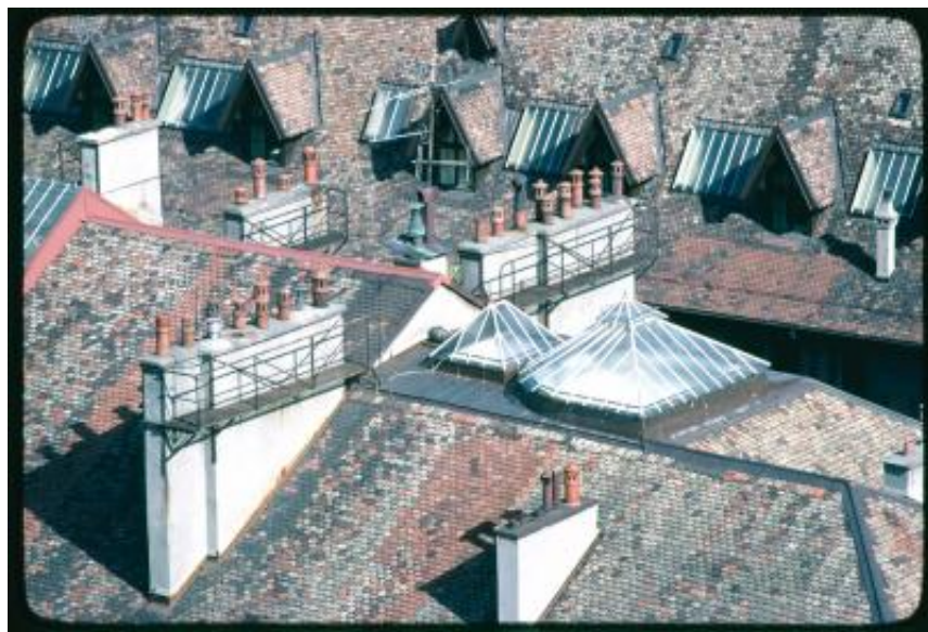
Dettaglio del tetto dell'edificio in Rue Verdaine al civico 11
