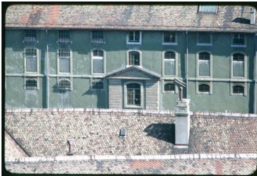
Facciata della prigione di Saint Antoine dal cortile
