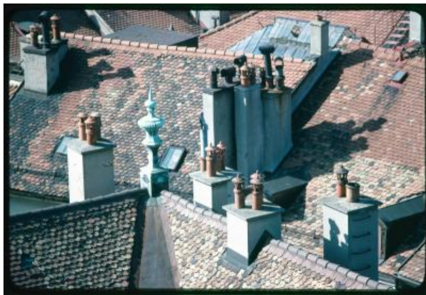
Veduta del tetto e dei comignoli della Maison Mallet a Ginevra
