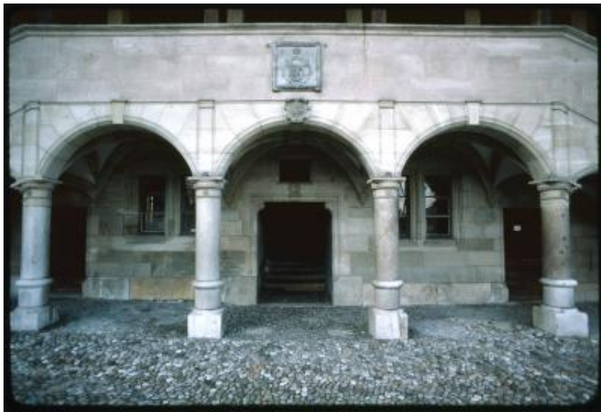
Dettaglio del sottoscala loggiato del Collège Calvin di Ginevra
