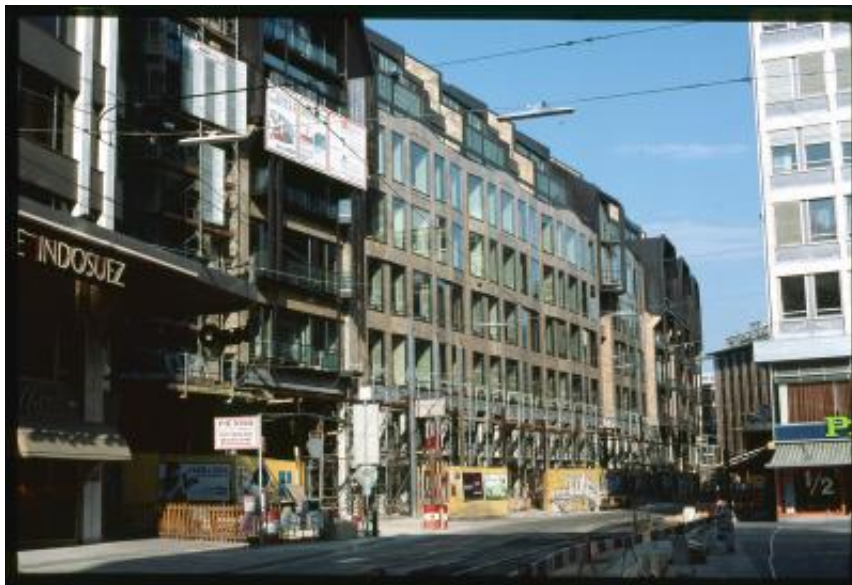
Veduta del cantiere del Confédération Centre in rue de la Confédération a Ginevra
