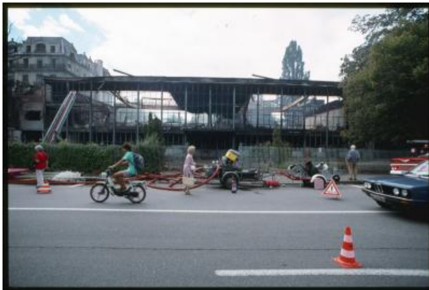
Il Pavillon du Désarmement il giorno seguente l'incendio del 1987, visto dalla strada
