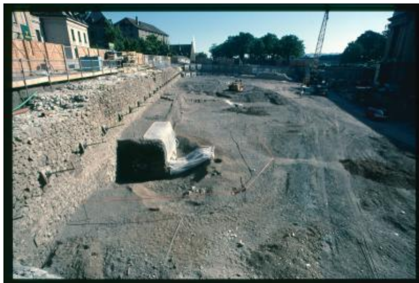
Muro antico individuato all'interno di un cantiere a Saint Antoine a Ginevra
