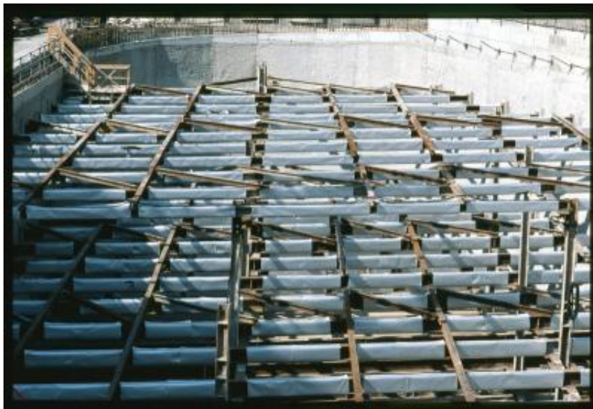
Dettaglio dei lavori di costruzione del parcheggio Saint-Antoine
