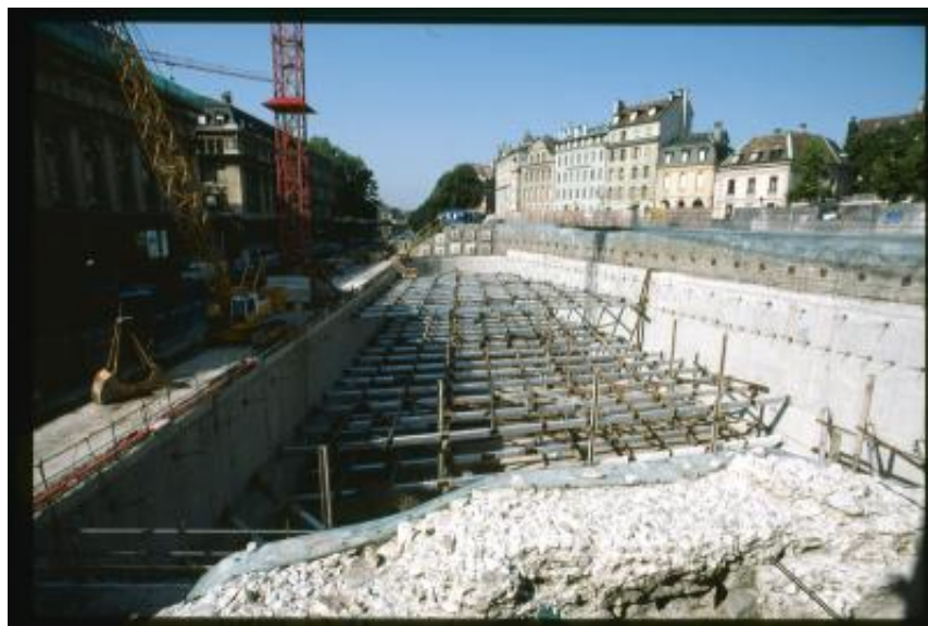
Veduta sul cantiere del parcheggio di Saint-Antoine e sugli edifici limitrofi
