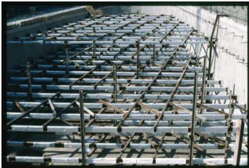
Dettaglio dei lavori di costruzione del parcheggio Saint-Antoine
