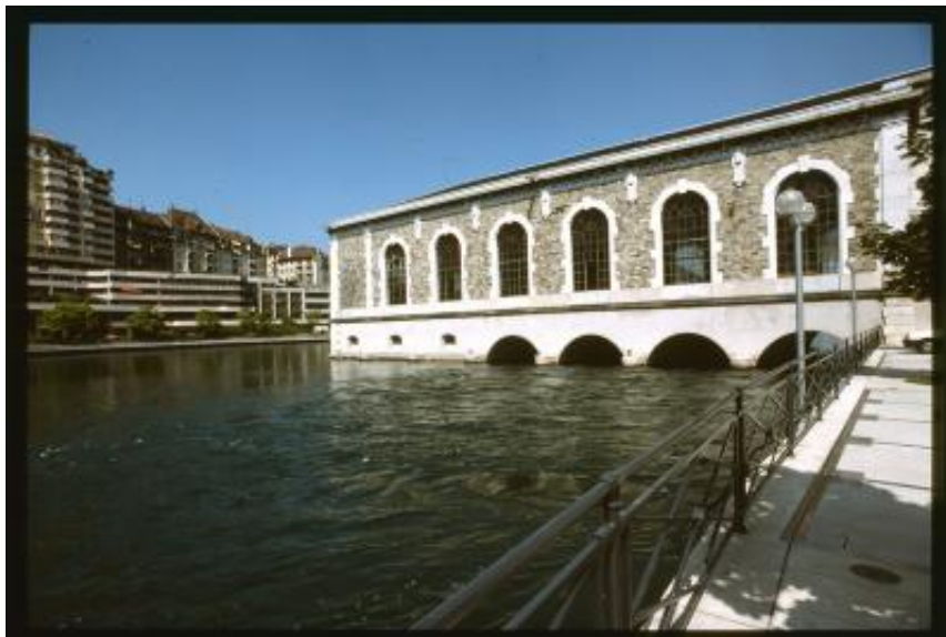
Veduta del Bâtiment des Forces Motrices e della sponda di Seujet del Rodano
