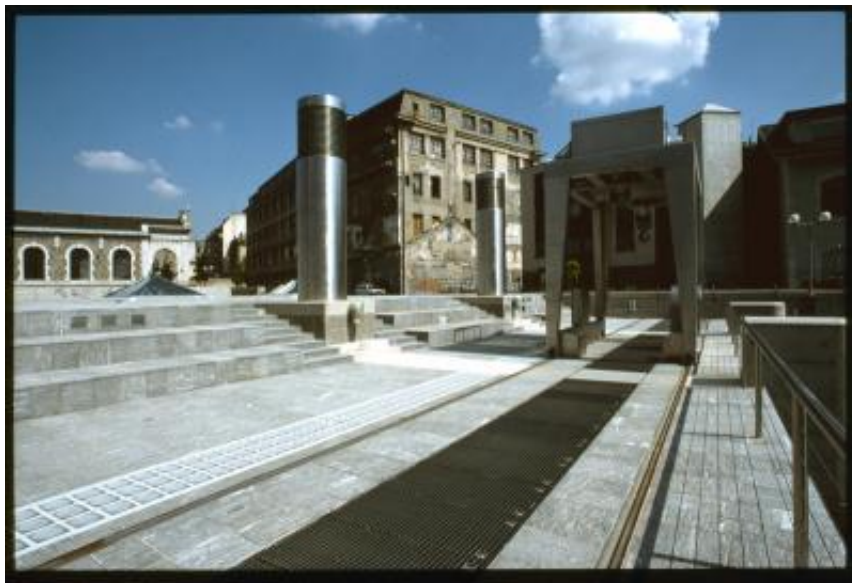
Veduta del Bâtiment des Forces Motrices ed edifici limitrofi dalla piattaforma del Barrage-du-Seujet
