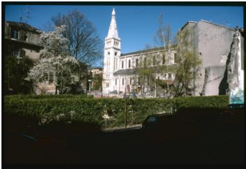
Fiancata laterale della chiesa di San Francesco da Sales, visto da rue Prévost-Martin
