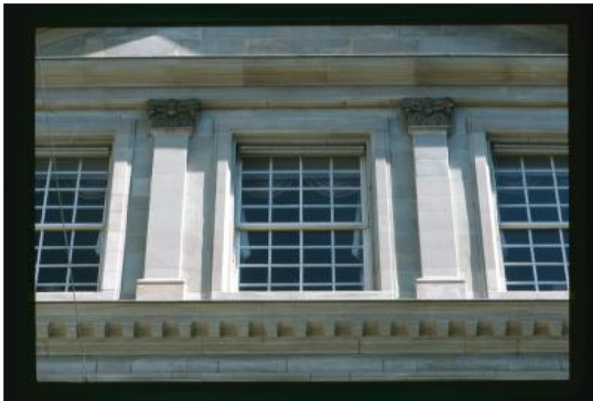
Ginevra. Dettaglio di alcune finestre della facciata della Maison Mallet
