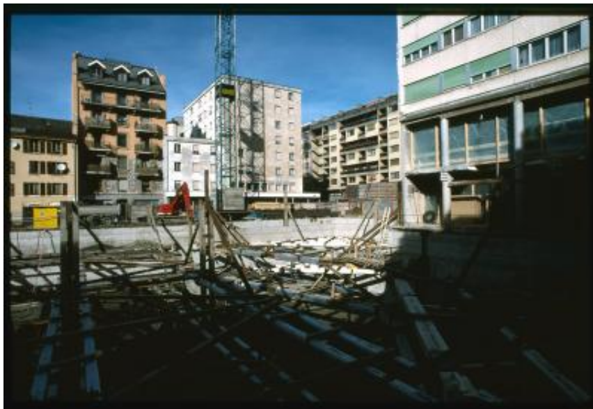
Ginevra. Cantiere della Migros
