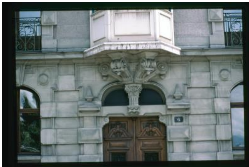
Ginevra. Dettaglio della facciata di un edificio in Boulevard de la Tour
