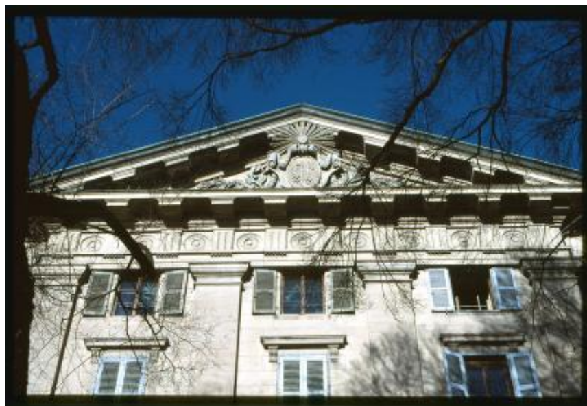
Ginevra. Frontone dell'ex caserma in Rue des Granges
